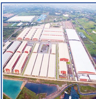
NHÀ MÁY WORLDON
