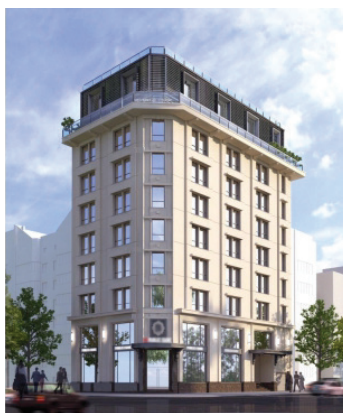
TÒA NHÀ 28A TRẦN HƯNG ĐẠO
