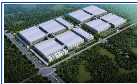
NHÀ MÁY GOERTEK - BẮC NINH
